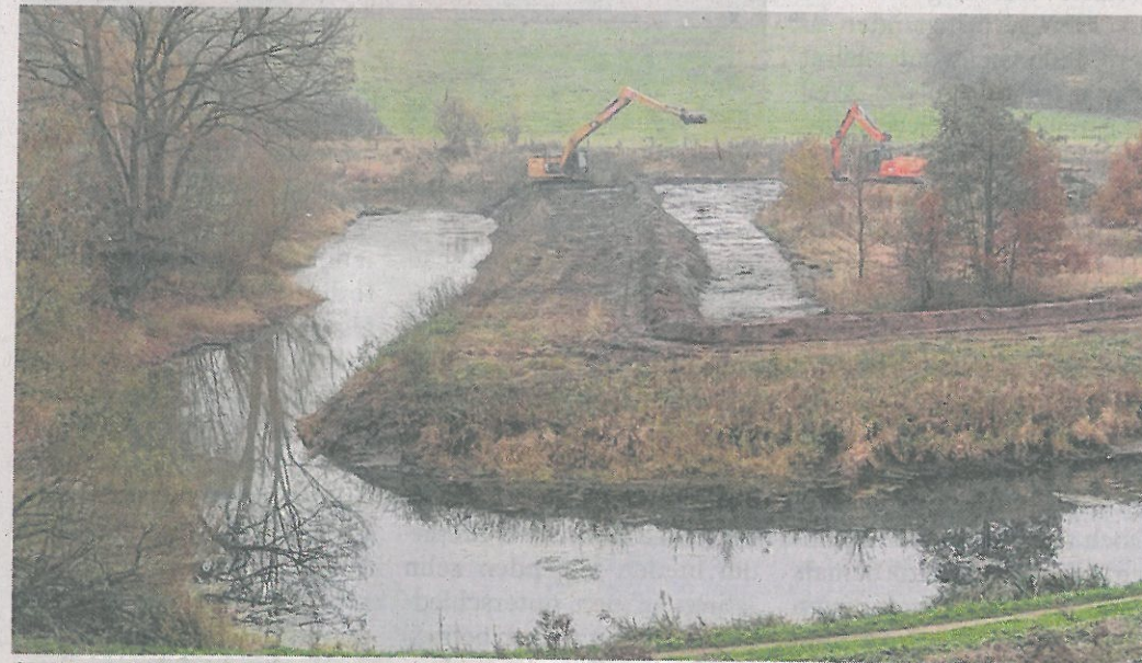
Am Kneeden arbeiten zwei Bagger für den Gewässerschutz und befreien die Trave von Schlammablagerungen. ST
